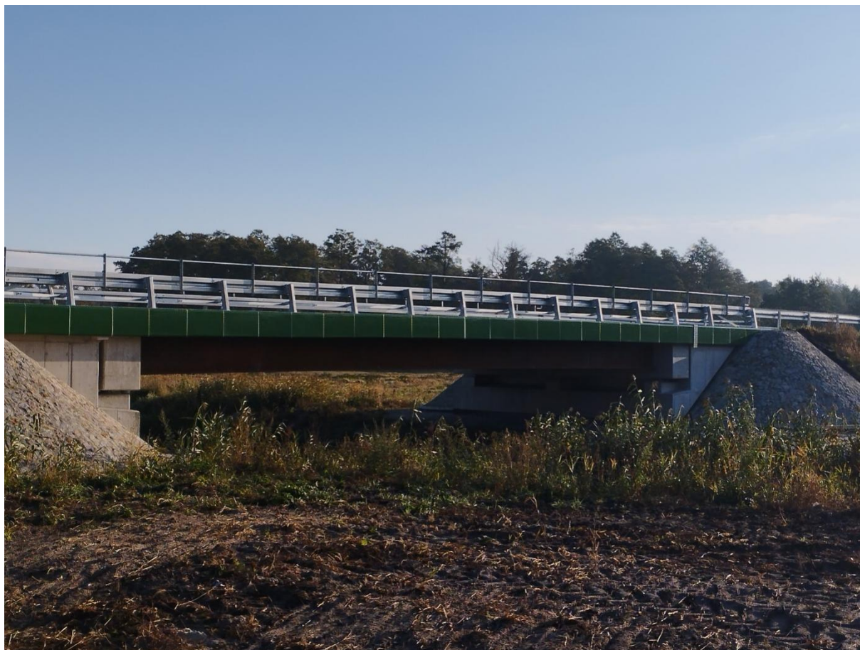
Zdjęcie 1 most w m. Perkowice w ciągu dr. pow. Nr 1067L
